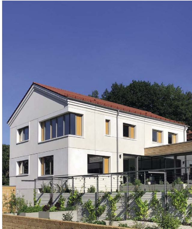
Abb. 5.3: Wohnhaus mit Fassade aus Sandwichelementen
