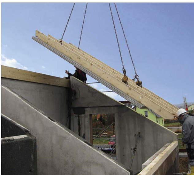
Abb. 10.1: Einbau eines Massivdaches
