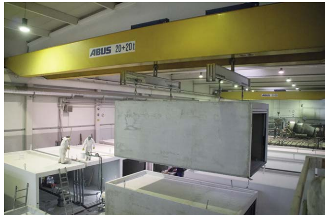
Abb. 6.2: Vorfertigung der Raummodule im Werk
