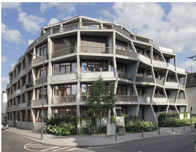
Abb. 1.1: Aufgelöste Fassade mit Architekturbetonfertigteilen
