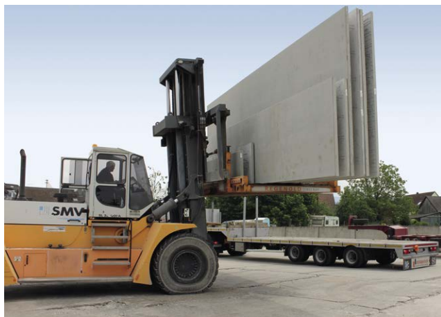
Abb. 1.4 und 1.5: Die Betonbauteile werden im Werk verladen und mit dem Lkw just-in-time auf die Baustelle geliefert.
