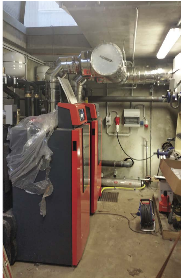
Abb. 13.7: Technische Anlagen arbeiten Tag und Nacht – allerdings nicht geräuschlos. Die Raumzelle für die Technische Gebäudeausrüstung ist aber weit genug entfernt vom sensiblen Wohnbereich.
