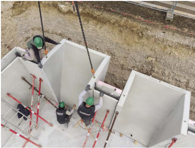
Abb. 9.3: Montage von Lichtflutern auf der Baustelle
