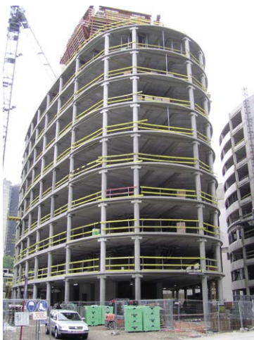
Abb. 15.3: Aus rechteckigen Deckenplatten lassen sich auch unregelmäßige Grundrisse realisieren.
