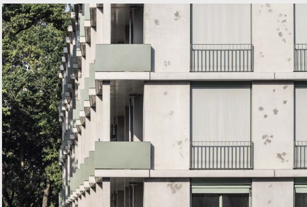
Abb. 16.17: Die Fassade und Balkone sind aus Betonfertigteilen.
