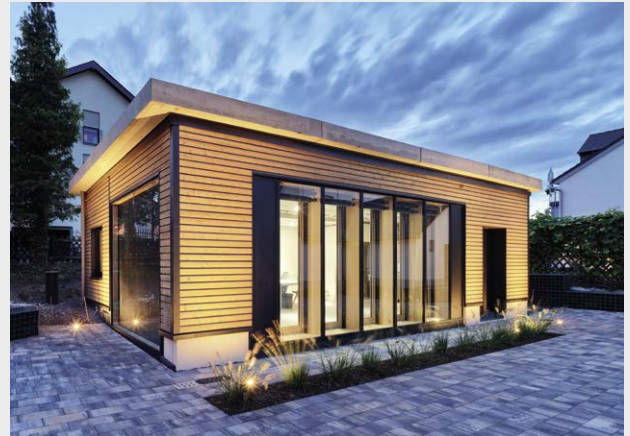
Abb. 16.13: Gesamtansicht des energieautarken Gebäudes
