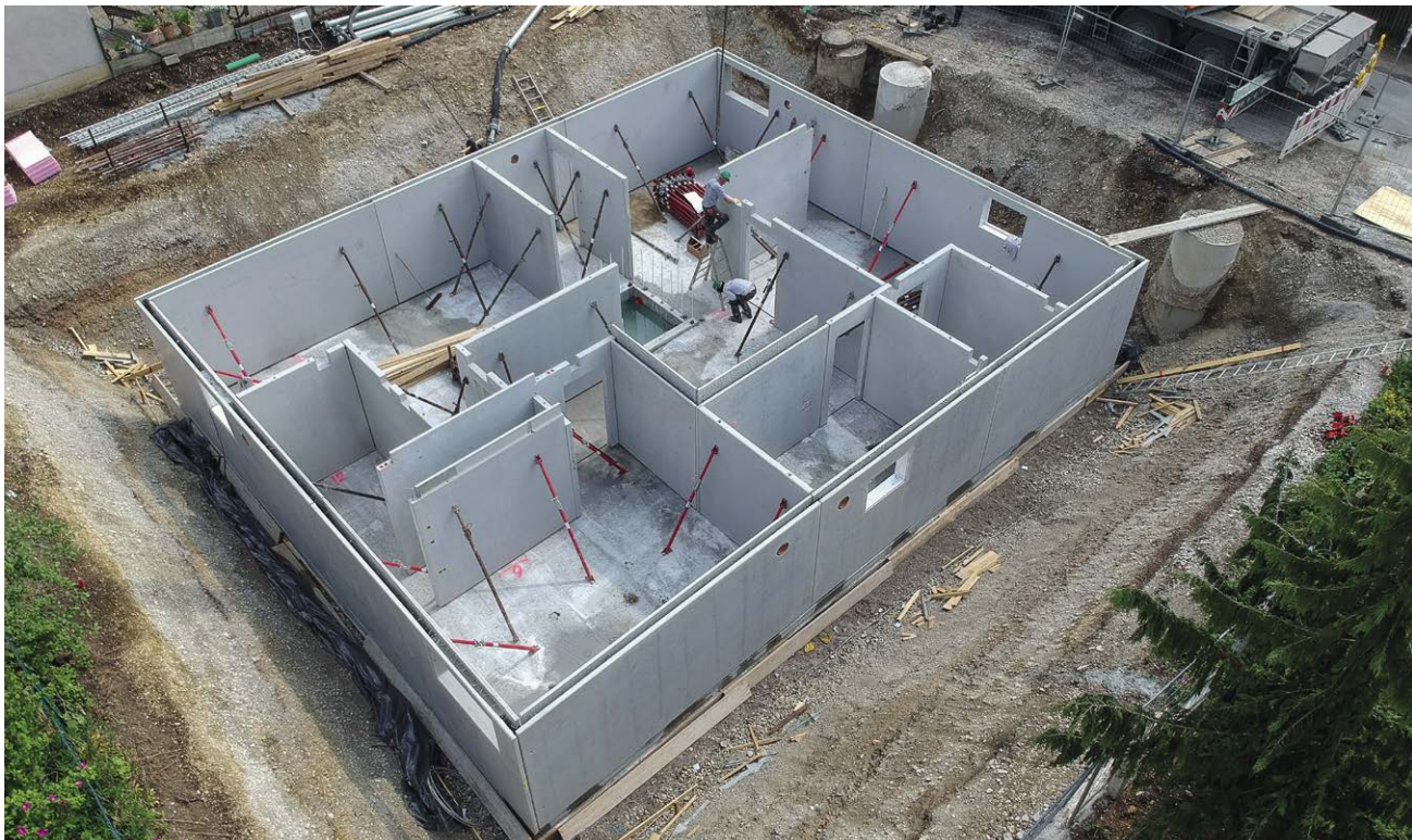
Abb. 9.1: Fertiggeller aus vorgefertigten Betonelementen verkürzen die Bauzeit.
