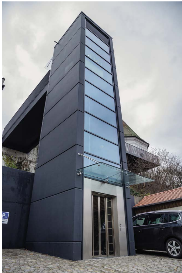
Abb. 7.4: Aufzugsschacht aus vorgefertigten Betonelementen
