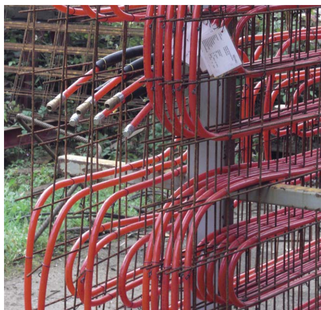
Abb. 14.3: Vorkonfektionierte Rohrregister für die Betonkernaktivierung zum Einbau in einem Fertigteilwerk
