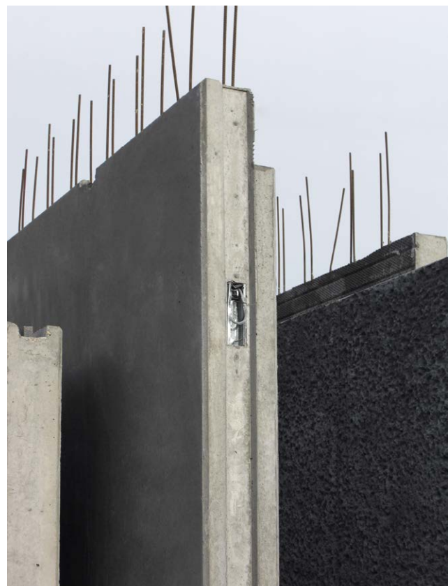
Abb. 4.1: Massive Wandelemente mit Anschlussbewehrung
