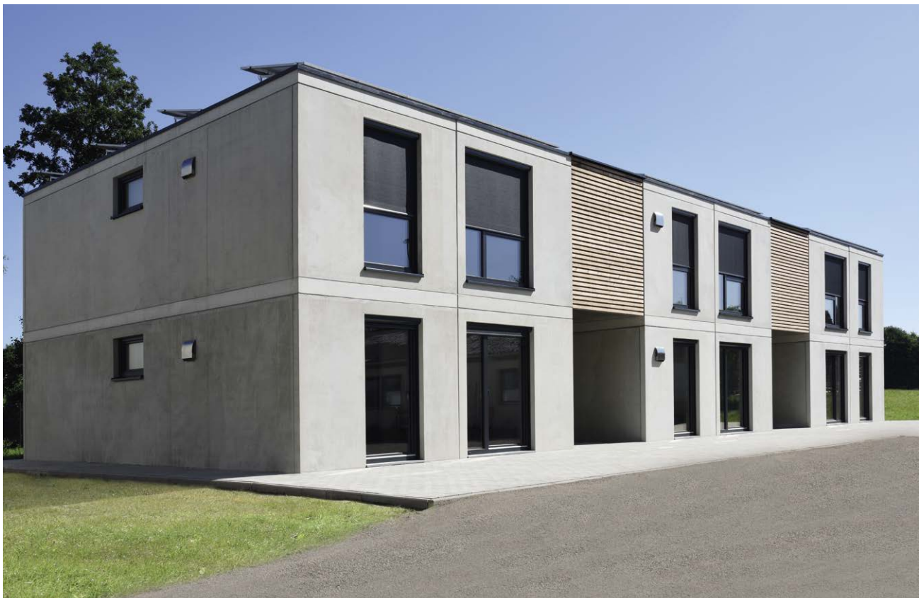
Abb. 6.1: Mehrfamilienhaus aus Raummodulen
