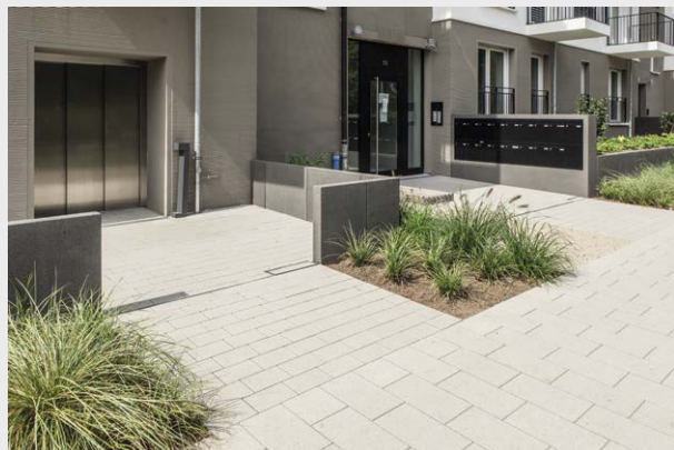
Abb. 16.22: Der Eingangsbereich punktet mit verschiedenen Betonbauteilen.
