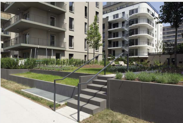
Abb. 16.20: Treppenanlage aus Blockstufen runden die Außenanlage ab.
