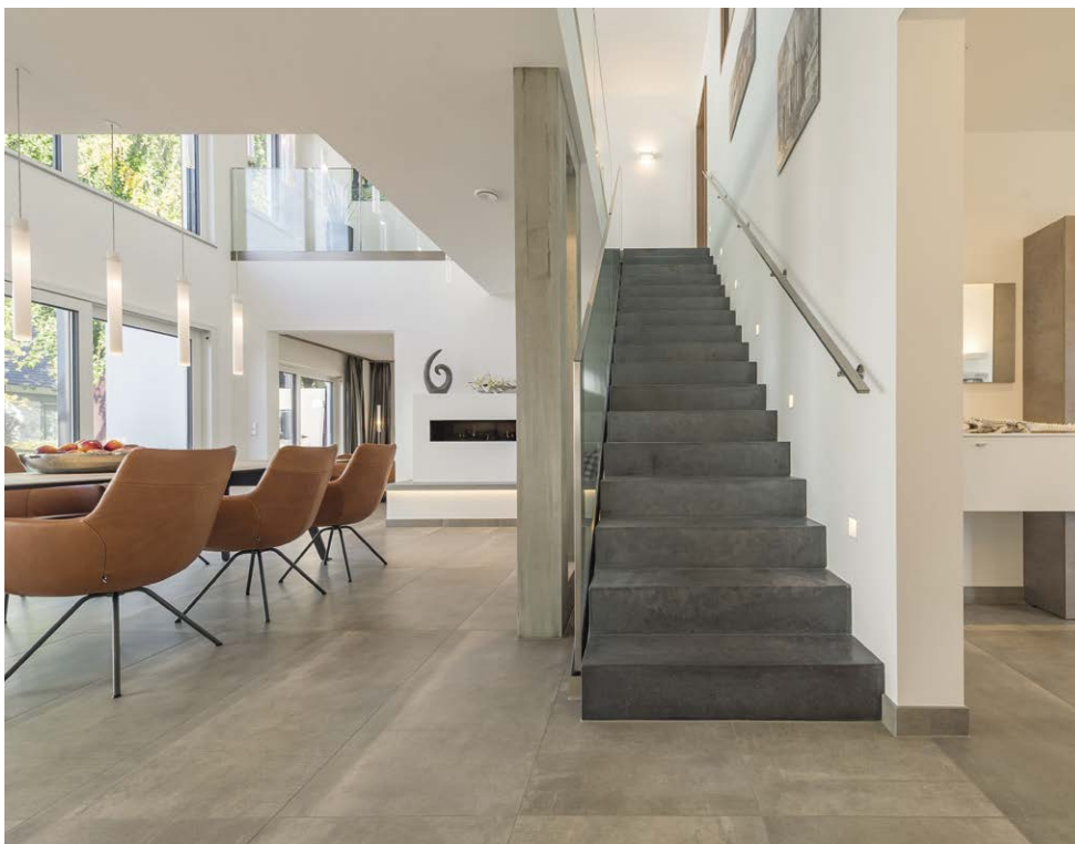
Abb. 7.1: Betonfertigteil-treppe in Sichtbetonqualität als Gestaltungselement
