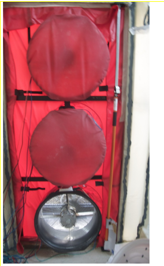
Abb. 7-1 Ventilatoren für den Luftdichtheitstest [FOS11]
